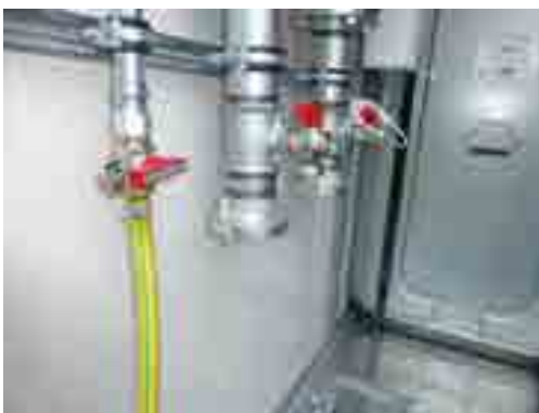
Bild: Kugelhahn der Entlüftungsleitung öffnen
