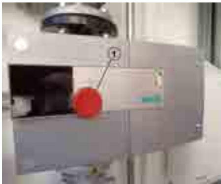
Bild: Pumpenleistung verändern
