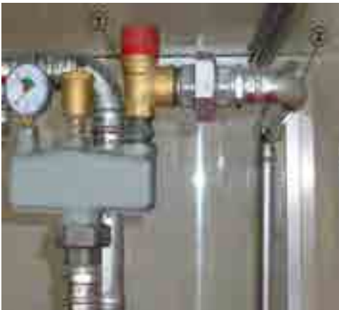
Bild: Innenansicht, Sicherheitsventil
