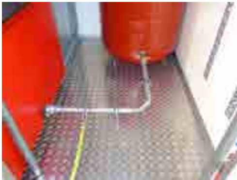
Bild: Entleer-Kugelhahn öffnen und Wasser ablassen
