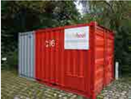
Bild: Heizcontainer aufstellen
