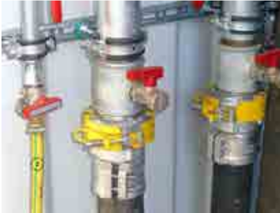
Bild: Kugelhahn der Entlüftungsleitung öffnen
