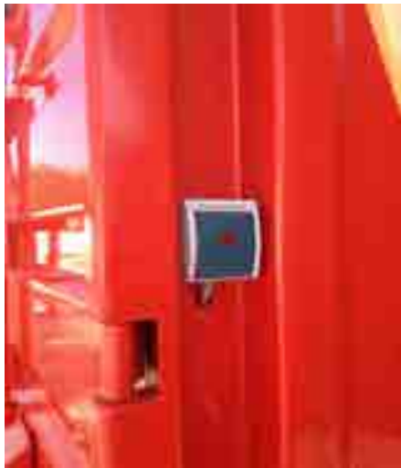
Bild: Heizungs-Notschalter
