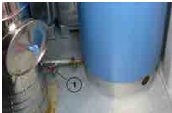
Bild: Entleer-Kugelhahn öffnen und Wasser ablassen
