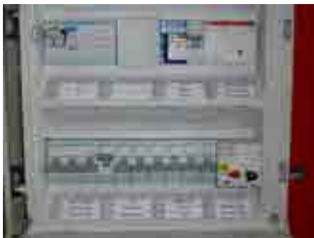
Bild: Auslöser des Fehlerstrom-Schutzschalters nach oben drücken
