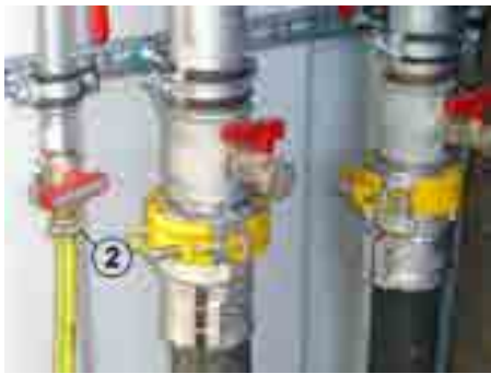
Bild: Entlüften des Heizcontainers
