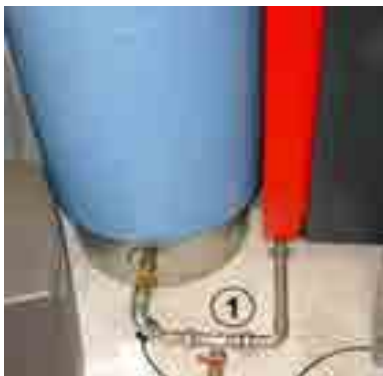
Bild: Befüllen des Heizcontainers
