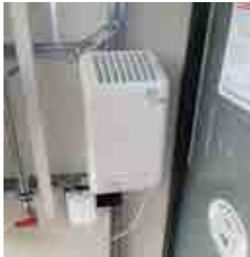
Bild: Frostschutzlüfter
