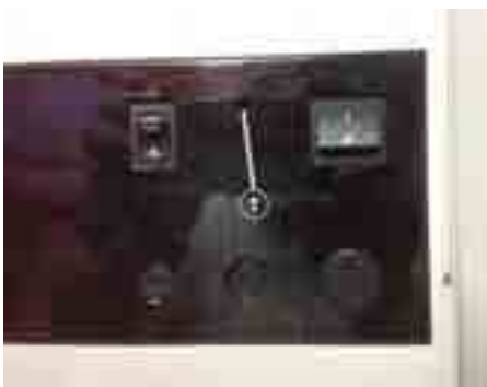
Bild: Entsperrung Übertemperatur
