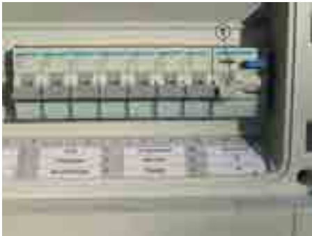
Bild: Auslöser des Fehlerstrom-Schutzschalters nach oben drücken
