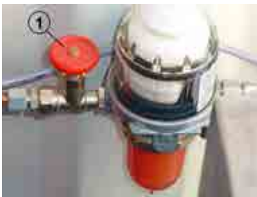
Bild: Ventil Ölfilter
