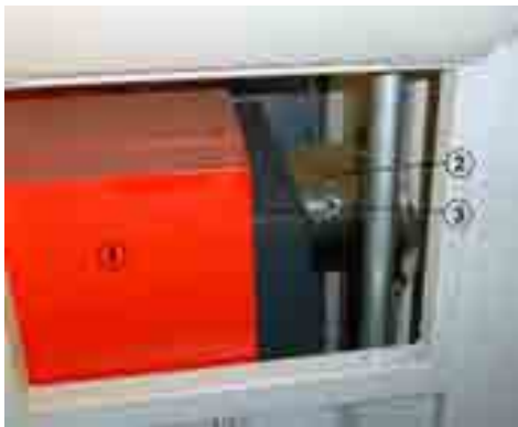
Bild: Innenansicht Kaminlucke
