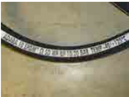
Bild: Kennzeichnung Anbindeleitung
