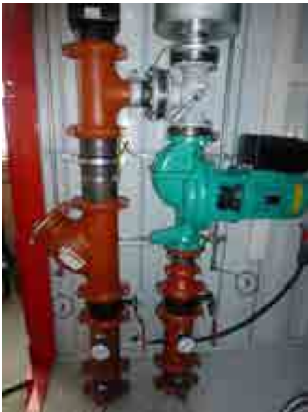
Bild: Entlüften des Heizcontainers
