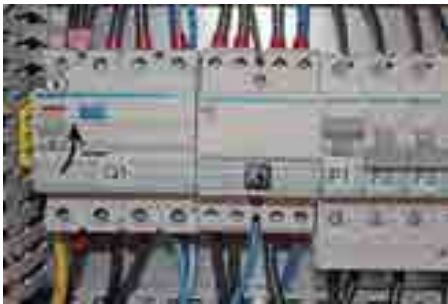
Bild: Auslöser des Fehlerstrom-Schutzschalters nach oben drücken
