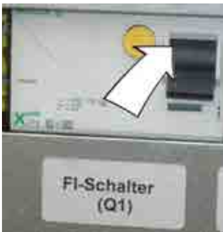
Bild: Auslöser des Fehlerstrom-Schutzschalters nach oben drücken
