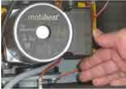
Bild: Pumpendrehzahl umschalten
