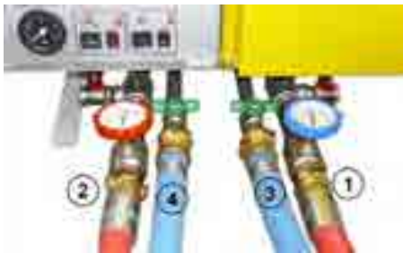
Bild: Kugelhähne mit Thermometergriff schließen
