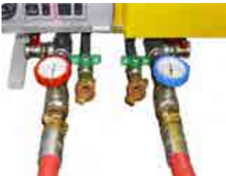
Bild: Kugelhähne mit Thermometergriff schließen
