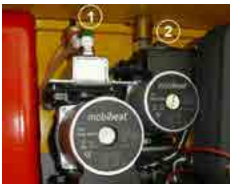
Bild: Entlüftungsschraube schließen
