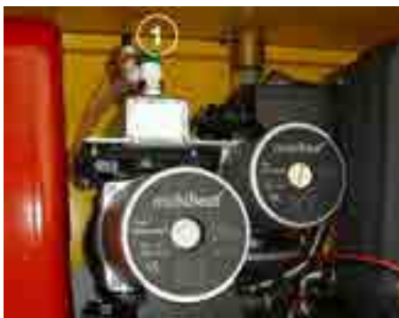
Bild: Rücklauf-Schraubkappe schließen
