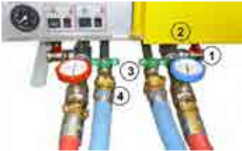
Bild: Entlüftungsschraube öffnen
