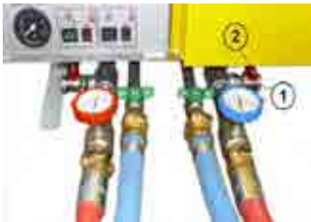
Bild: Schraubkappen öffnen
