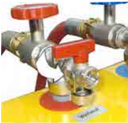
Bild: Kugelhahn der Entlüftungsleitung öffnen
