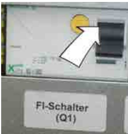
Bild: Auslöser des Fehlerstrom-Schutzschalters nach oben drücken
