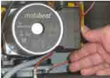
Bild: Pumpendrehzahl umschalten
