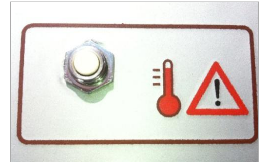
Abb. 1: Taste zur Inbetriebnahme nach dem Entstören.
